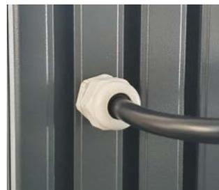
Kabelführung in Säulenprofile 458.000.100
